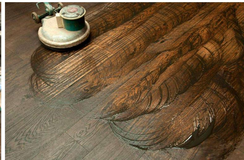
Die gelösten typisch schwarze Öl-Dreck-Schlieren lassen sich im Anschluß problemlos mit einem Abzieher und Kehrblech abnehmen
